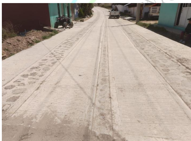
Suministro de materiales para construcción de Concreto, San Francisco y San Sebastián.
