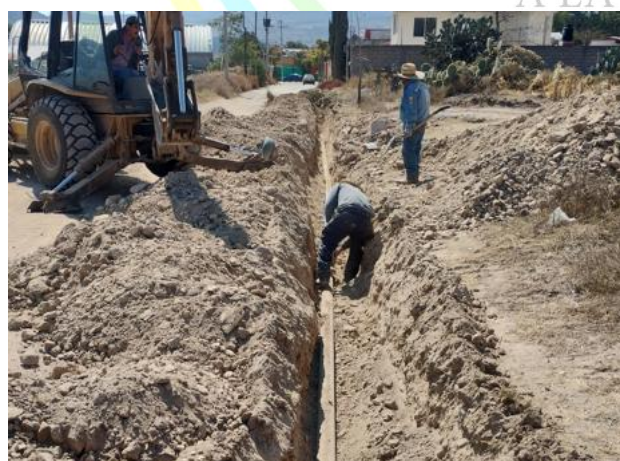
Suministro de materiales para drenaje sanitario, Comunidad Benito Juárez.
