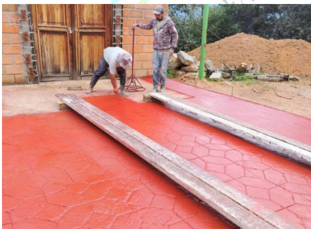
Rodadas de Concreto barrio La Compañía, Comunidad Mineral del Chico
