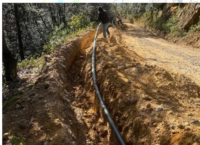
Rehabilitación de Sistema de Agua Potable, Comunidad Mineral del Chico
