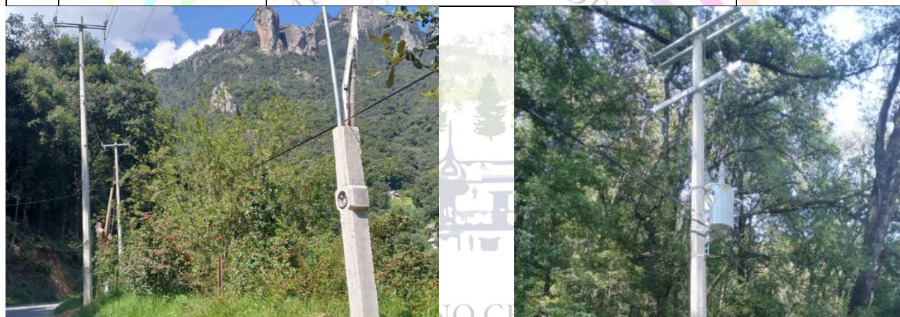
Ampliación de red eléctrica El Puente camino a Mineral del Chico.
