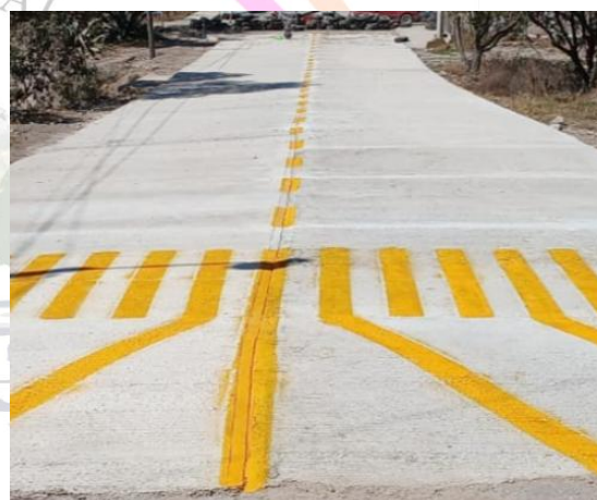
Concreto Premezclado para Pavimentación de Calle Principal de la Comunidad de Benito
