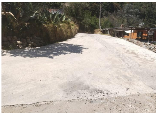
Rodadas de Concreto y muro de contención, Comunidad La Presa.
