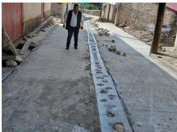
Rehabilitación de concreto en Calle Columba Rivera. Cabecera Municipal
