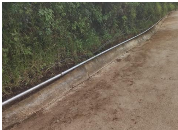
Suministro de material de tubería galvanizada para red de agua potable, Barrio La Palma
