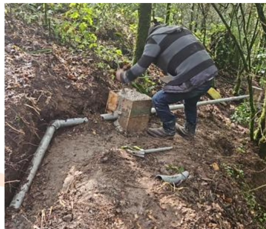
Construcción de línea de conducción de agua potable, Comunidad San Simón Lo de Rojas.
