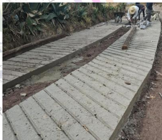
Rodadas de Concreto en camino rumbo al Aguila, Comunidad San José Capulines
