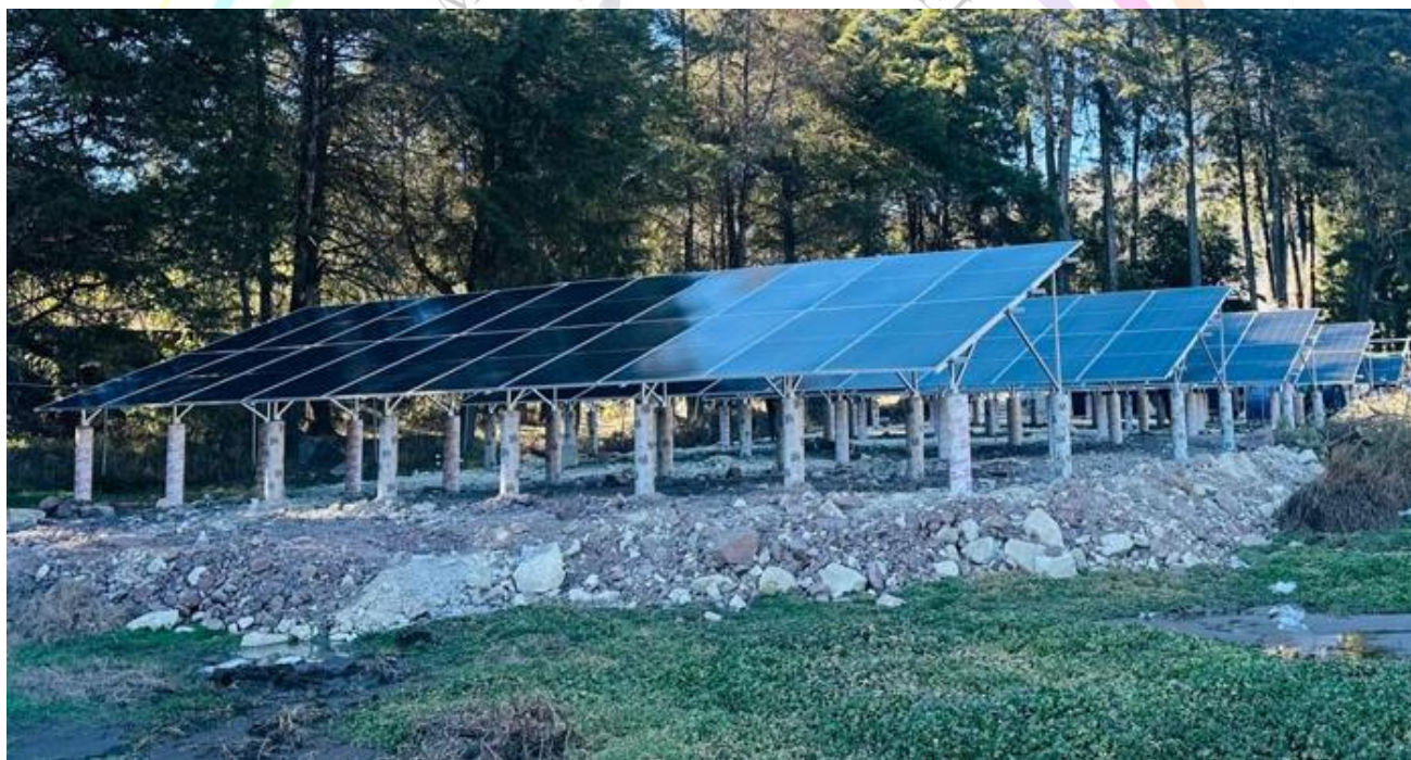
Suministro de Paneles Solares para Sistema de Agua Portable en la Comunidad de La Estanzuela.
