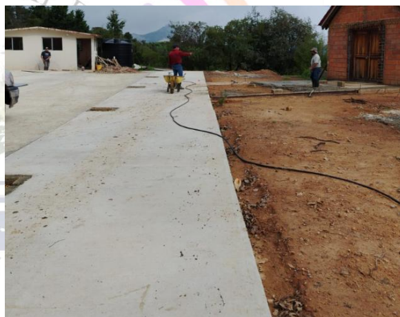
Empedrado en Concreto ahogado calle 2 de noviembre, Comunidad Mineral del Chico
