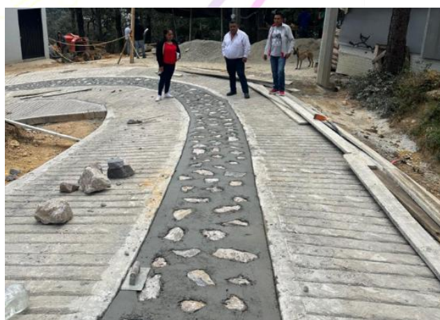
Construcción de rodadas de concreto hidráulico en Barrio La Compañía.
