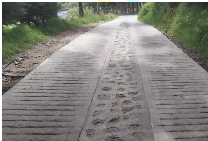
Rodadas de Concreto calle principal, Comunidad Carboneras Barrio Cueva Blanca.
