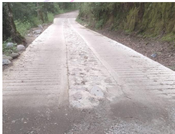
Rodadas de Concreto camino rumbo al Ocote, Comunidad Carboneras Barrio Cueva
