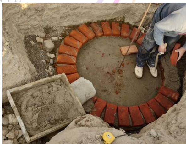
Suministro de materiales para drenaje sanitario, Comunidad Estanzuela.
