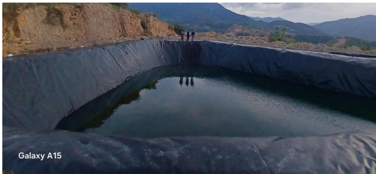
Adquisición y Suministro de Geomembrana para Olla de Captación de Agua Potable, Tierras Coloradas.
