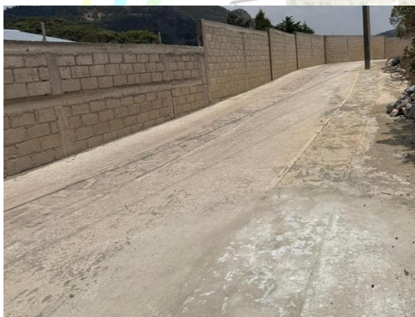
Rodadas de Concreto detrás de Escuela, Comunidad San José Capulines
