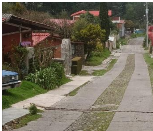
Rehabilitación de drenaje pluvial y banquetas, comunidad de Carboneras.
